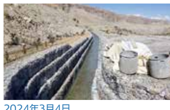
2024年3月4日 バラコット用水路完成間近
